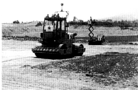
写真 2-4 リフト厚 (50 cm) に締め固め
