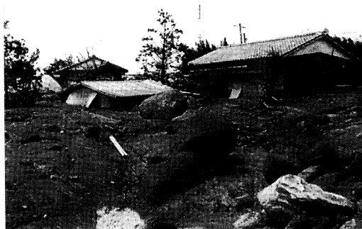
写真 2-1 土石流により埋没した家屋 (H 5, 4, 29)
