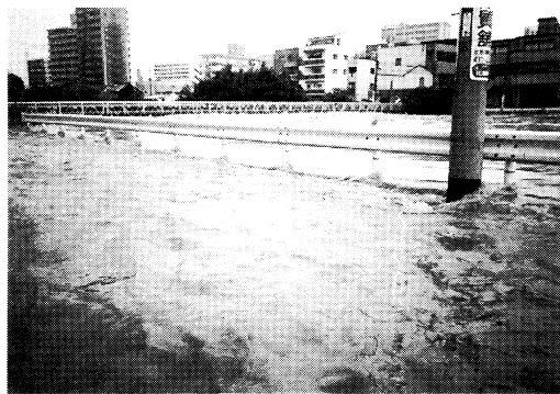
写真1 博多区比恵町比恵橋付近の越流状況((株)日高合金提供)(ガードレール手前側が道路、向こう側が御笠川で、左方向が下流になる。)
