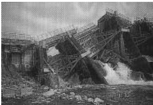
写真1 1999年台湾集集地震による被害(石岡ダムの決壊)
