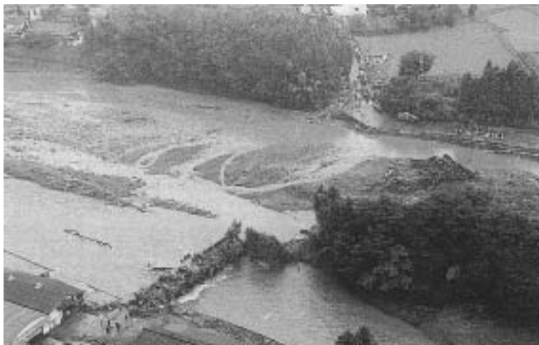
図2 余笹川の橋の流失
