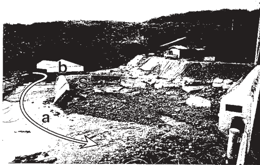
写真1 西之表市浅川の民家流出現場
