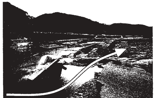
写真8 西之表市小牧野の榕橋流出現場
