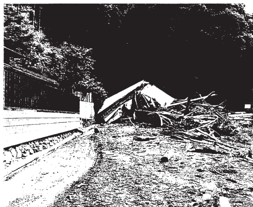
写真 8 水俣市井良迫地区で見られた土砂流出
