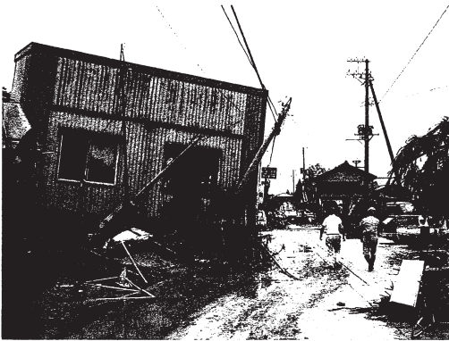
写真2 中之島町の破堤箇所付近の家屋 複数の住家が建物ごと流されたり破壊され たりしている。図4のA地点。
