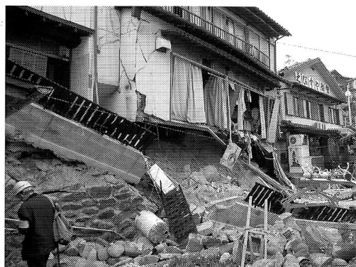
写真1 玄界島の宅地被害状況
