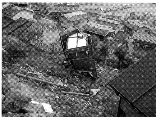
写真2 玄界島の家屋倒壊状況
