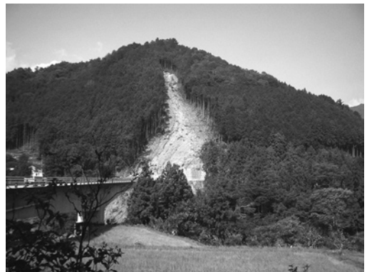
写真2 小滝地区の表層崩壊と土砂流下跡(以下, 場所については, 図10参照)
