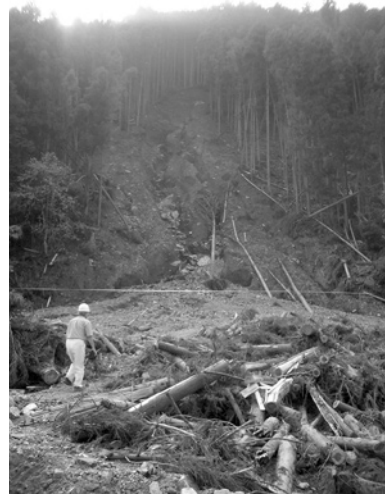
写真5 三軒家地区の斜面崩壊
