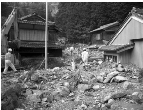
写真4 久豆地区の土砂流出と集落被害
