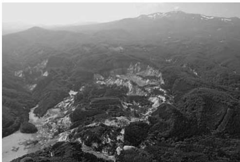
写真1 荒砥沢ダム貯水池上流の大規模岩盤地すべり。末端部は、手前の尾根に衝突した後、向きを変えて、貯水池に流入した（撮影：王功輝）。
