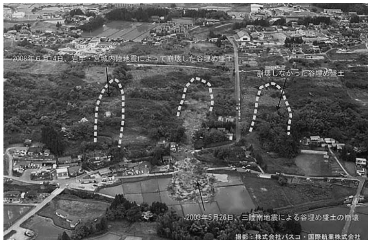
図6 旧築館町館下における谷埋め盛土の崩壊箇所。2003年撮影の斜め空中写真（撮影：パスコ）に加筆した。
