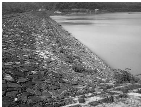
写真6 荒砥沢ダムの貯水池側斜面に残された津波の痕。地震発生前に湖面に浮いていた流木やゴミが、津波によって持ち上げられた。高さは、約2.5m。
