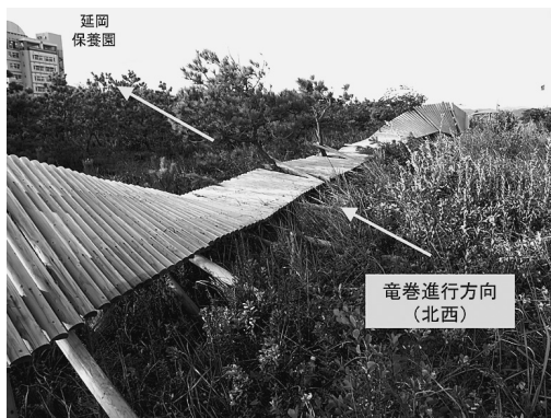
写真2 竜巻が上陸した海岸における防砂棚の転倒状況(塩浜町1丁目, 2006年9月19日撮影)
