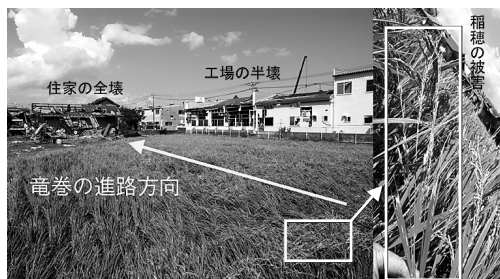
写真7 水田の穂ずれ被害、家屋・工場の被害状況（浜町，2006年9月19日撮影）
