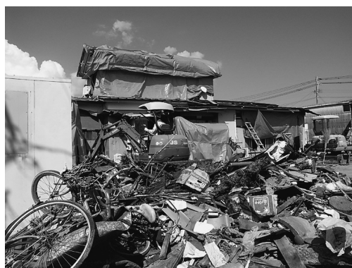
写真9 家屋の全壊被害の状況（別府町，2006年9月19日撮影）
