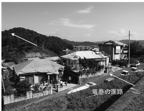
写真16 家屋の被害状況(富美山町, 2006年9月 19日撮影)
