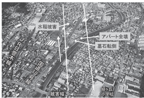
写真4 竜巻による被害の状況(緑ヶ丘・浜町, 2006年9月19日撮影)
