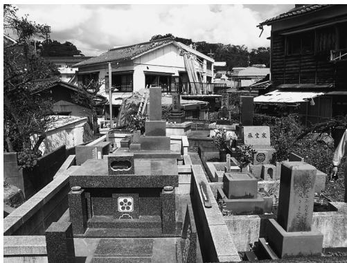
写真15 円照寺における墓石転倒の状況(山下町, 2006年9月19日撮影)
