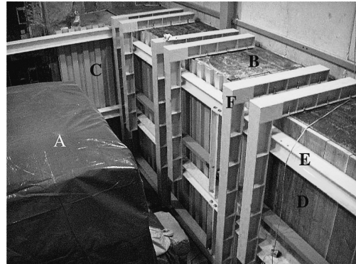
写真3 発掘孔内の石室、クレーンベース敷鉄板および壁面保護のための仮設支保工の設置状況 A: 発掘された石室（保護のためにカバーで覆っている） B: クレーンベースの敷鉄板 C: アルミ製波形矢板 D: 木製矢板 E: 鋼製の腹起こし F: 鋼製のL型抑え治具
