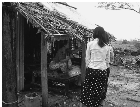
写真6 Thilewaa Port近くの農家(N16度39分42.6秒, E96度15分36.1秒) 農業用の水路を伝わって水が流入し、軒下まで浸水した。
