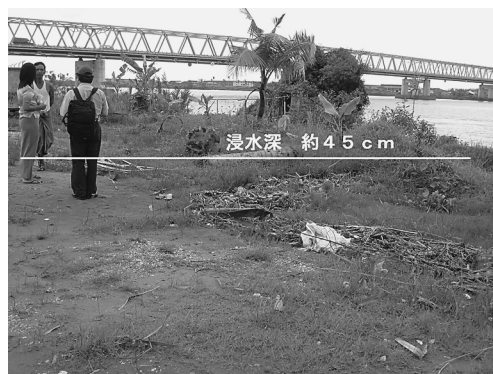
写真11 ヤンゴン川支流 (河口より64km) での浸水
