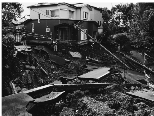
写真2 新潟県中越地震による長岡市高町団地の被害。崩壊した部分は、谷頭部の盛土である。
