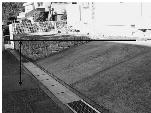
図2 地盤沈下による被害の一例（杭で支持された構造物と沈下によって標高の下がった道路）
