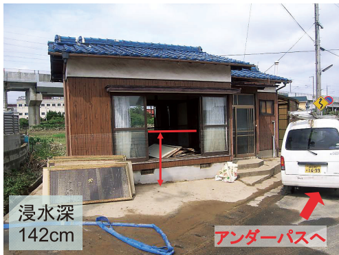
写真5 アンダーパス南側の被害家屋（山陽小野田市厚狭，2010年7月16日撮影）
