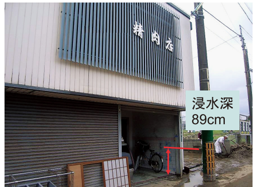
写真6 商店街内の商店の被害状況（山陽小野田市厚狭，2010年7月16日撮影）
