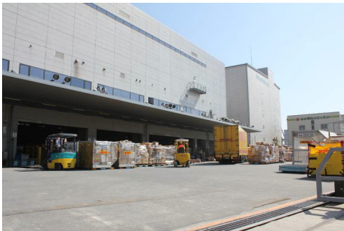
写真4 液状化被害が軽微な事業所（新木場）
