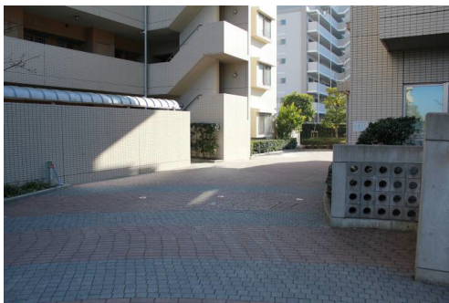
写真13 液状化していないエリア（浦安市日の出）
