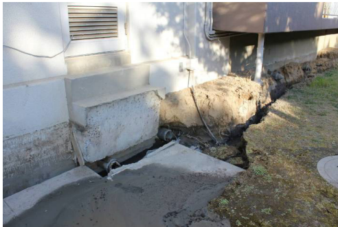
写真11 ライフラインの破断（浦安市入船）
