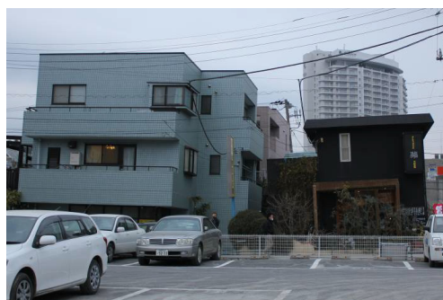
写真9 傾斜した建物 (浦安市入船)
