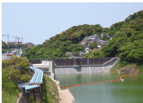
写真4-2 概成した本河内低部ダム
