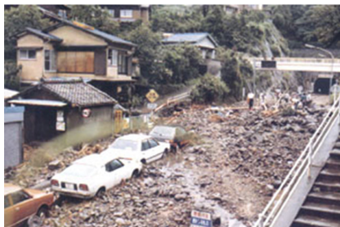
写真3-1 日見トンネル西口付近(本河内町)
