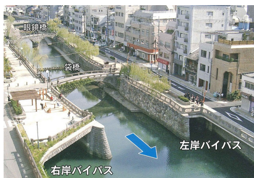
写真4-1 完成したバイパス水路
