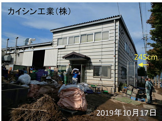
写真12 北部工業団地における浸水被害・浸水深と当時の浸水状況 (撮影方向は「北部団地ご案内」の地図に記載: ネコ X@yamato6464, 2019)
