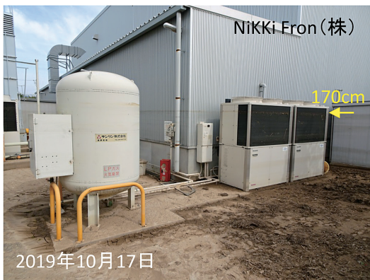
写真12 北部工業団地における浸水被害・浸水深と当時の浸水状況 (撮影方向は「北部団地ご案内」の地図に記載: ネコ X@yamato6464, 2019)
