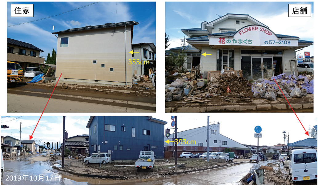
写真15 豊野町土浮地区の被害状況 (2019年10月17日撮影)
