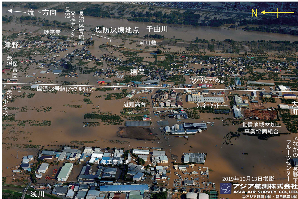
写真2 決壊当日の10月13日（撮影時刻は不明）に撮影された長野市の千曲川中流左岸の穂保地先における堤防の決壊と堤内地への浸水状況（アジア航測株式会社，2019年）
