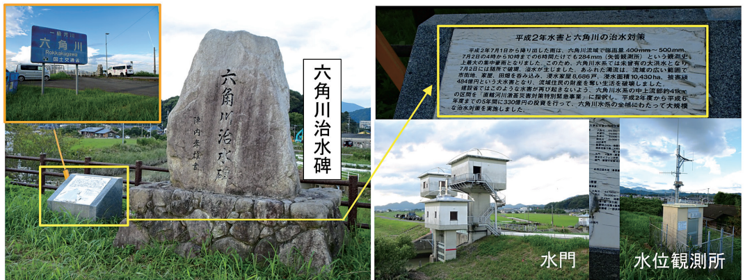
写真1 「六角川治水碑」と水門・水位観測所
