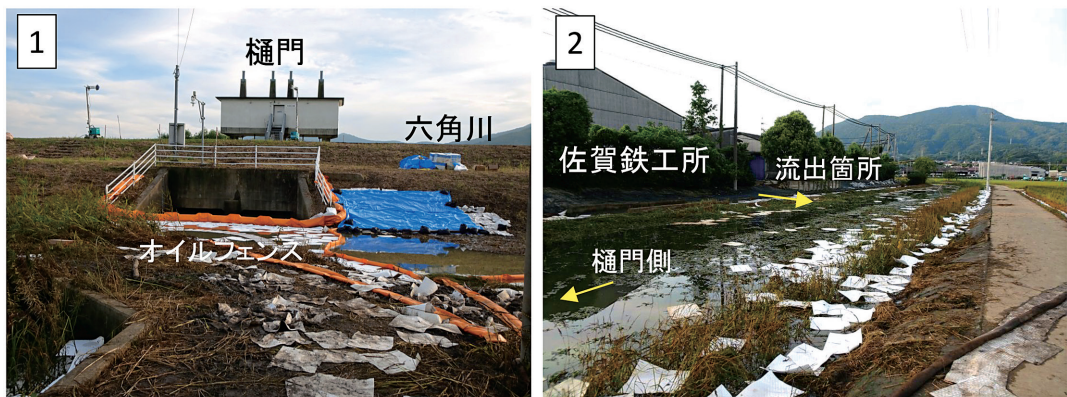
写真4 樋門の閉鎖とオイルフェンスの設置による六角川への油の流入防止 (1) と佐賀鉄工所から流出した油の吸着マットによる撤去 (2) (2019年9月2日撮影)
