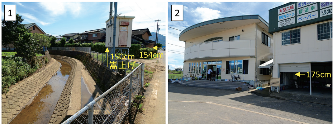
写真9 高橋水位観測所(1)と武雄自動車学校(2)の浸水高(2019年9月5日撮影)
