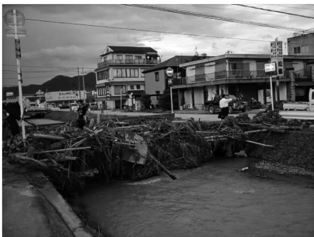
図1 (a) 都市域の河川での流木集積(2014年福知山市弘法川), (b) 橋梁での流木による全面閉塞(2017年福岡県大肥川, 橋本ら(2018))
