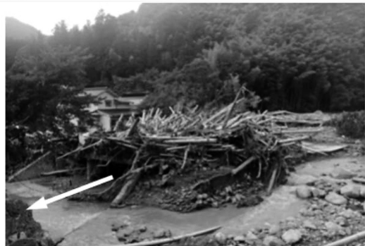
図1 (a) 都市域の河川での流木集積(2014年福知山市弘法川), (b) 橋梁での流木による全面閉塞(2017年福岡県大肥川, 橋本ら(2018))
