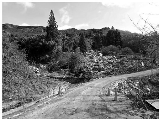
写真6 緩斜面の崩壊で犠牲者発生地の推定地点付近(宮城県丸森町子安)
