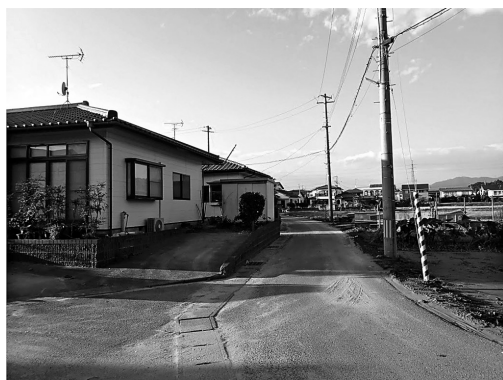
写真7 床上浸水により犠牲者が発生したと推定される家屋（いわき市平下平窪）
