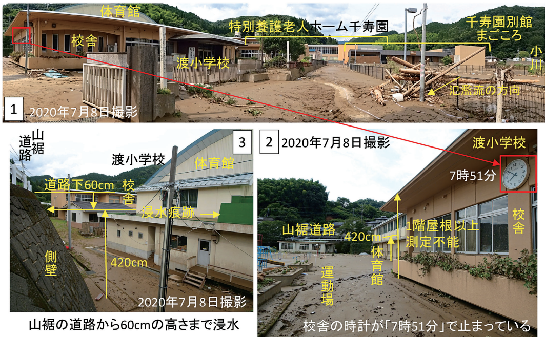
写真5 特別養護老人ホーム千寿園と球磨村立渡小学校の被災状況
