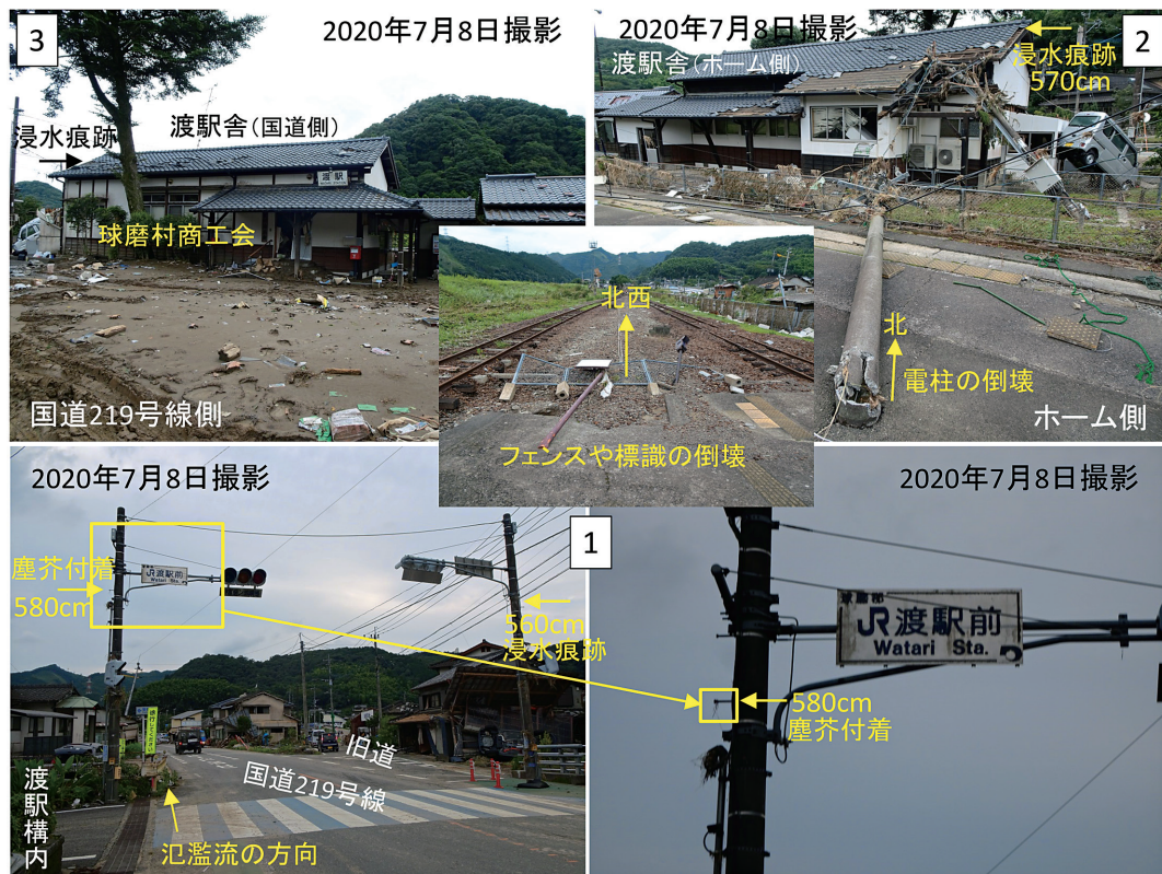
写真8 渡駅付近の被災状況
