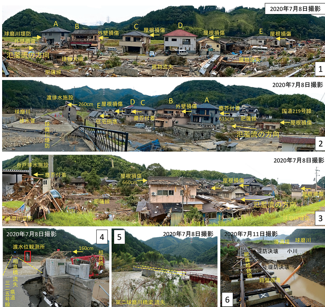
写真6 茶屋集落における被災状況 (①と②のA～Eの建物は一致)
