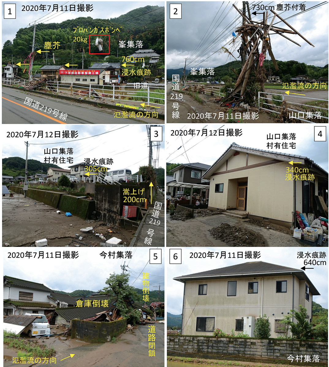
写真9 地下・今村・山口・峯の集落における被災状況
