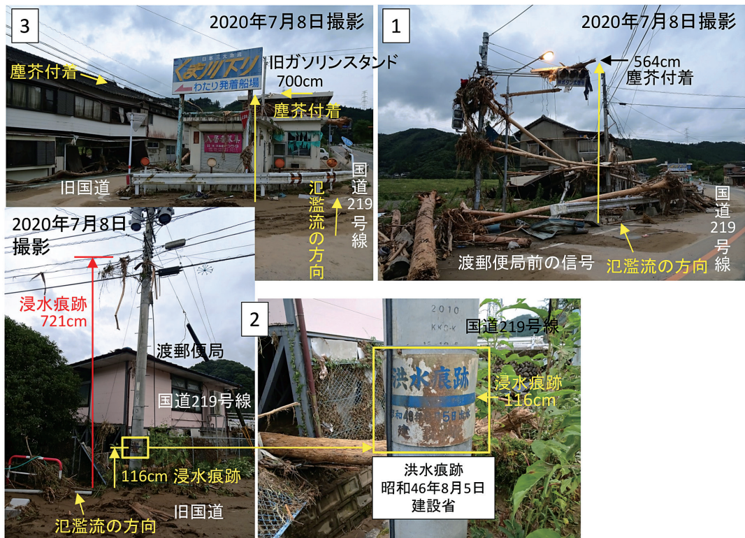
写真7 渡郵便局付近の被災状況
