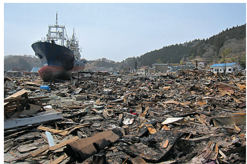
写真2 船舶および火災による被害（気仙沼市）（著者撮影）
