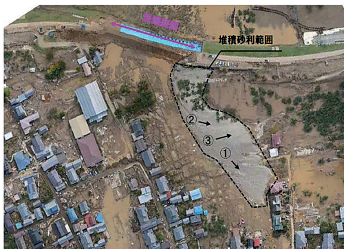
図12 桜づつみ堤防(側帯)のり面崩落地点、堆積物調査①堆積砂利最大3.0 m、②堆積1.5m、③堆積2.0 m 2019.10.18撮影(2020.2.2国土交通省住民説明会資料)
