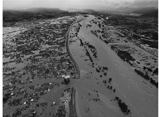
図24 千曲川左岸堤防決壊と洪水流（共同通信社提供）
