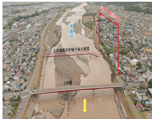
図32 洪水後の上田電鉄、上田橋の前後の河床変動は図33の洪水前と比較して左岸側の砂州が一扫されている（写真：千曲川河川事務所）
