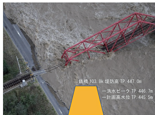
図30 上田電鉄の落橋(2019年10月13日午前8時40分:京都新聞ネット)、同箇所の水位の位置関係を加筆
