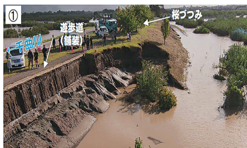
図9 桜つつみ堤防(側帯)崩落地点, 吸出し防止シートを境に裏のり面の崩落がみられる ①決壊部上流側 2019.10.13撮影(国土交通省資料)
