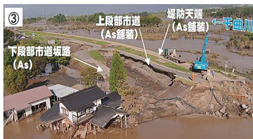
図11 ③桜つつみ堤防(坂路)のり面崩落地点, および堤防決壊地点の下流側である図5, 図6(B-B断面)。2019.10.13撮影(国土交通省資料)
