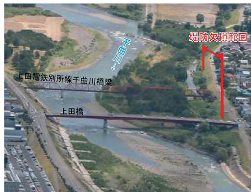
図33 洪水前の河床状況。左岸側に大きな砂州がみられる（写真：千曲川河川事務所）
