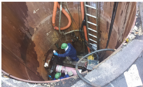
写真9 千葉市における集排水管設置状況
