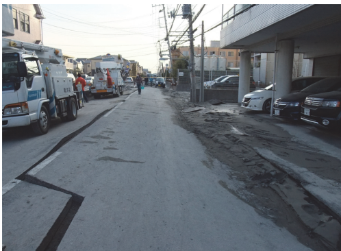
写真3 液状化により突き上げた道路 (浦安市)
