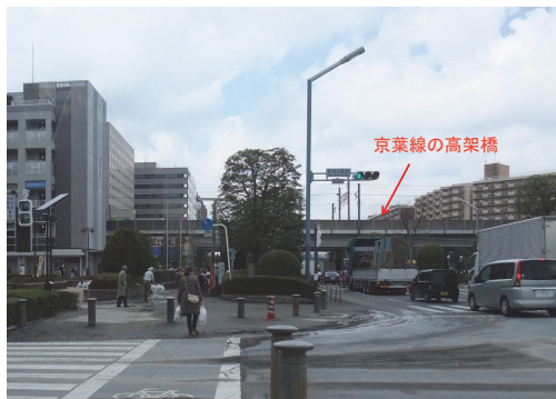
写真1 液状化で被災した新浦安駅前と被災しなかった京葉線の高架橋
