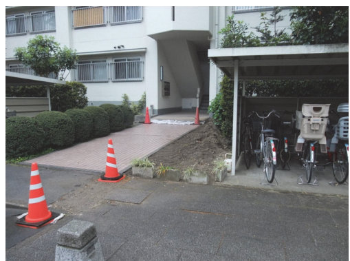
写真6 段差が生じたアパートの入り口 (浦安市)
