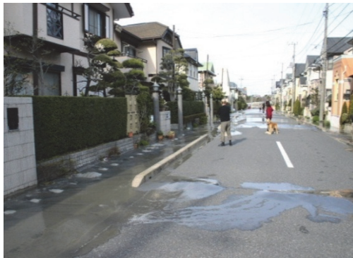
写真7 本震発生16分後(15:03)の状況(小川の撮影による) 3)
