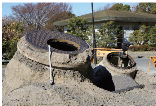
写真2 液状化による千葉県浦安市の耐震性貯水槽の浮上(2011年東北地方太平洋沖地震)
