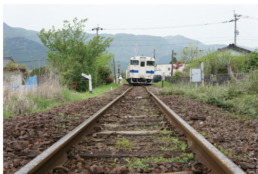
写真5 豊肥本線赤水駅近くで脱線した車両(2016年熊本地震)
