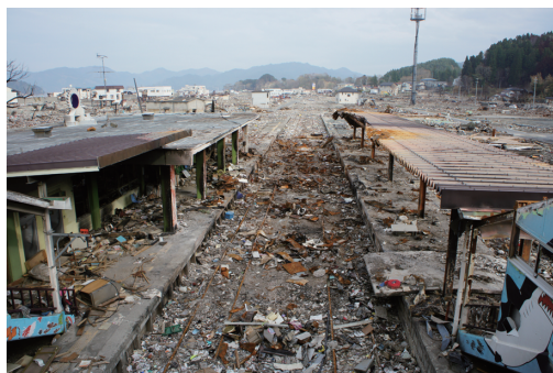
写真3 津波と震後火災によって被害を受けた岩手県内の三陸鉄道リアス線の陸中山田駅(2011年東北地方太平洋沖地震)
