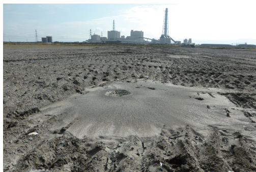
写真7 ブラックアウトの主要原因となった苫東厚真発電所近傍に残る多くの液状化跡(2018年北海道胆振東部地震)
