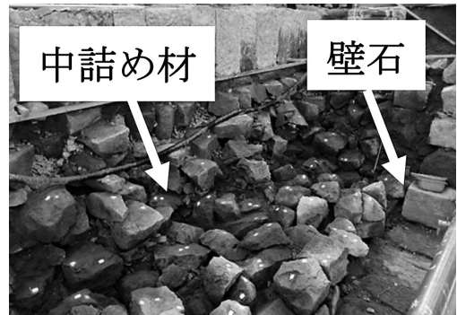
写真2 通潤橋の壁石と中詰め材 3)
