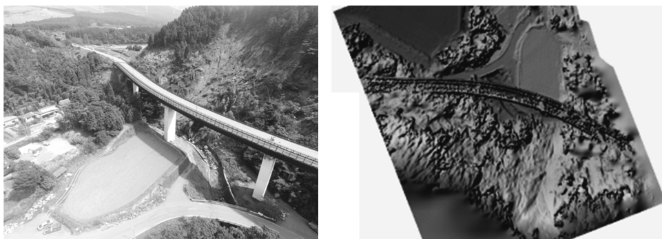
図4 熊本県西原村の大切畑大橋周辺のドローン空撮画像(左)とそれらから構築した3Dモデル(右)
