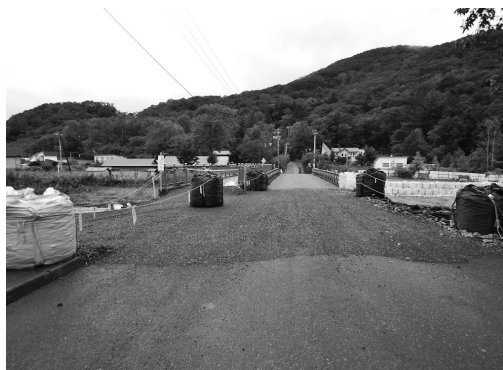
写真15 左後方集落住民の73歳男性が車で避難中、洪水により浸食された凹地(橋手前、撮影時点では復旧済み)に転落し死亡。集落は浸水想定区域でないが河川沿いの低地。2016年台風10号、北海道新得町西二条北3丁目。
