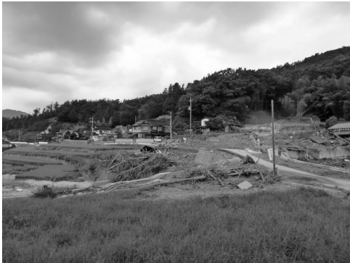
写真10 「避難先被災」犠牲者発生場所の一例。避難先の自治会集会所で土砂災害に見舞われた。平成26年8月豪雨、広島市安佐北区可部町桐原、86歳女性。
