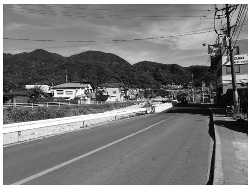
写真7 「避難行動あり・車で移動中」犠牲者発生場所の一例。家族4人で避難先に車で移動中、路肩が決壊した河川に転落し、子供2人が流され行方不明。平成30年7月豪雨、広島市安芸区畑賀、11歳女性・6歳女性。
