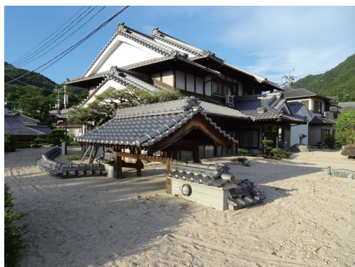
写真2 住宅の1階部分への真砂土の堆積 (2018年7月11日撮影)
