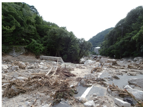
写真1 大屋大川上流の「大屋大川2号砂防堰堤」における土砂の堆積 (2018年7月11日撮影, 山本・他 (2019))
