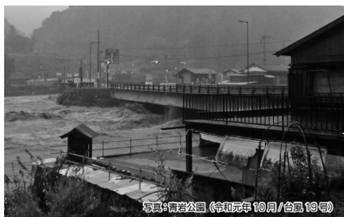
図5 令和元年東日本台風の際の青岩公園の様子 13)
