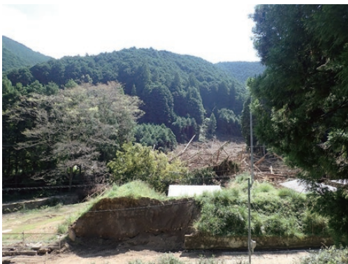
写真20 写真19の斜面崩壊で流出した土砂の末端部，10月4日撮影
