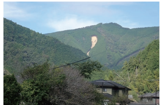
写真21 静岡市葵区油山付近の斜面崩壊，10月4日撮影
