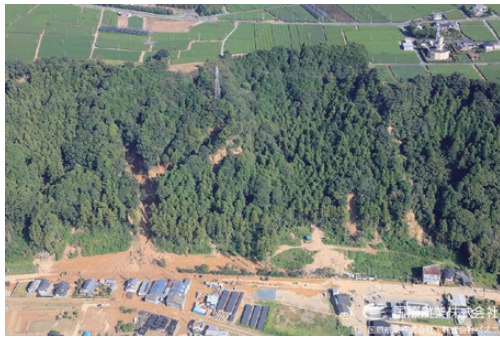
写真23 磐田市神増の斜面崩壊，国際航業撮影
