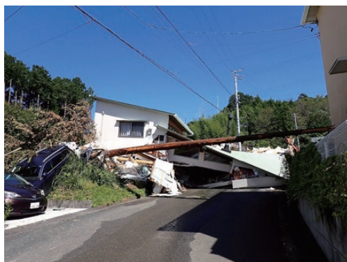
写真17 浜松市天竜区緑恵台での土砂災害，9月26日撮影
