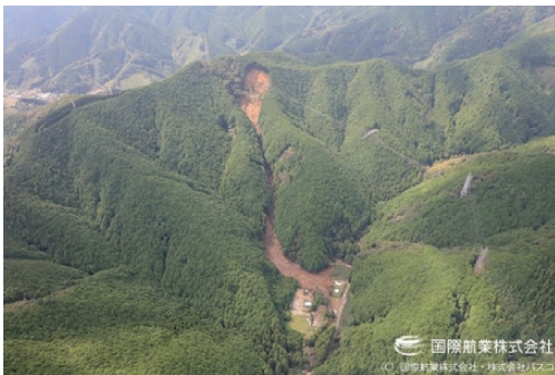
写真19 静岡市葵区足久保口組の斜面崩壊，国際航業撮影
