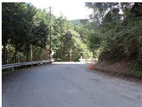
写真5 川根本町下泉の被災現場の下流側約25mから、10月15日撮影
