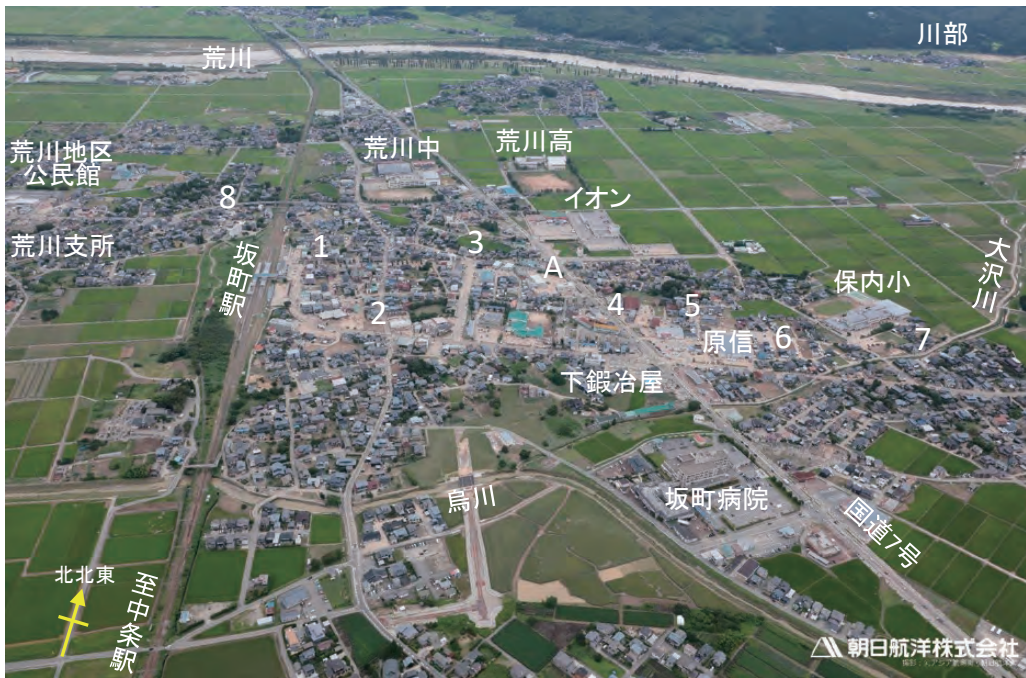
空中写真4 村上市下鍛冶屋周辺における浸水被害の状況 (朝日航洋株式会社提供, 2022) (1~8は写真9 [1]~[8]と一致, Aは羽越河川国道事務所)
