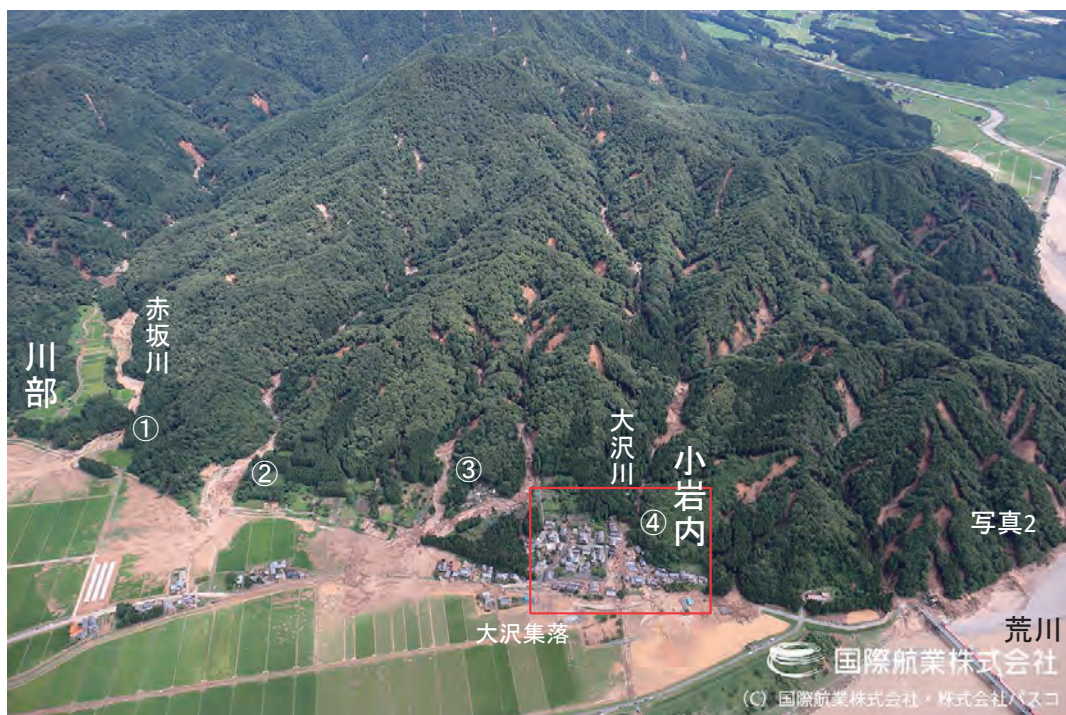
空中写真1 土石流が発生した村上市の小岩内・川部地区の被害状況(国際航業株式会社・株式会社パスコ, 2022) (①～④は大規模土石流の発生溪流, 赤色枠は空中写真2の範囲)
