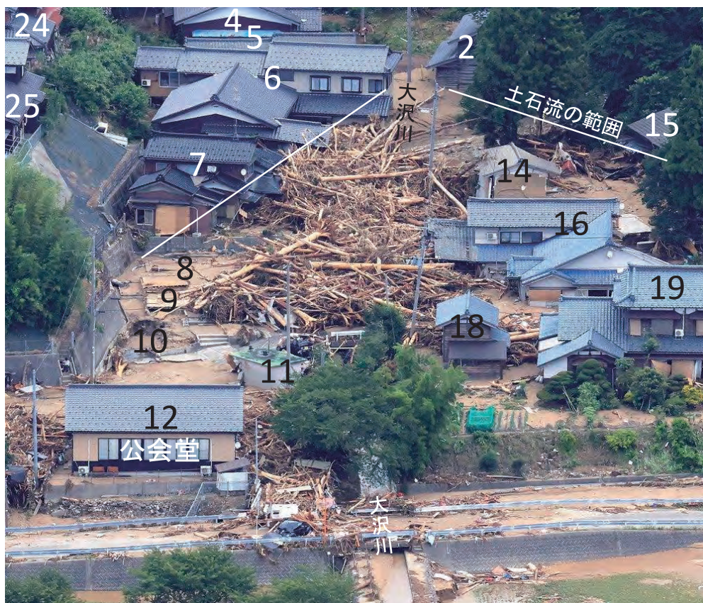
空中写真3 土石流が発生した小岩内地区の大沢集落における被害状況（読売新聞，2022）（8月5日9時撮影）（図中の数字は建物で空中写真2，図13，写真1と一致）
