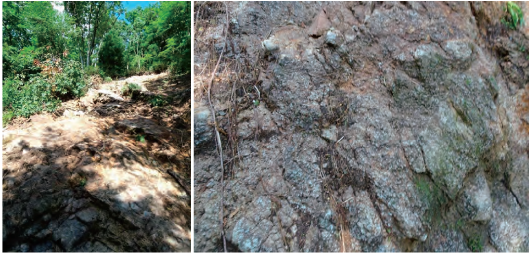
写真5 湯蔵川左岸の急傾斜地の崩落と風化花崗岩の状況（2022年8月17日撮影）
