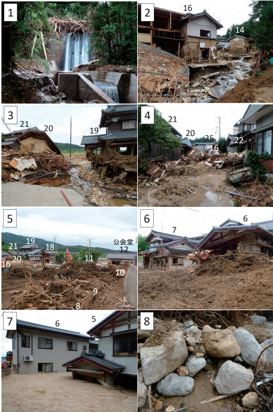
写真1 小岩内地区の大沢集落における被害状況 (2022年8月17日撮影, 図中の数字は図13, 空中写真2・3と一致)
