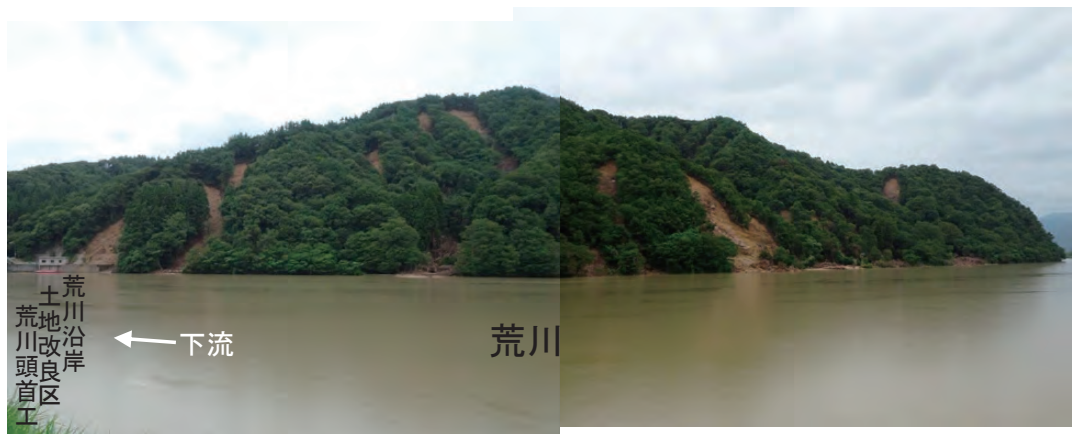
写真2 土石流が発生した村上市の小岩内地区 (2022年8月18日撮影)
