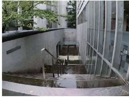
復旧後 (左の線が当時の水位線)
