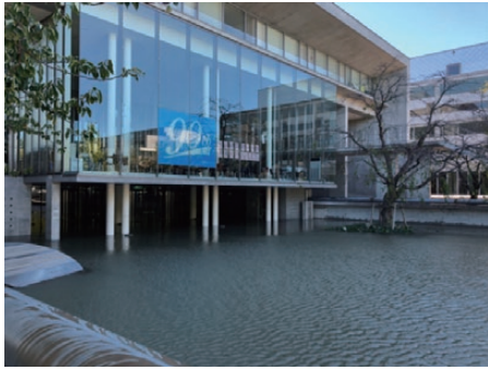
浸水状況 (10/13撮影)
