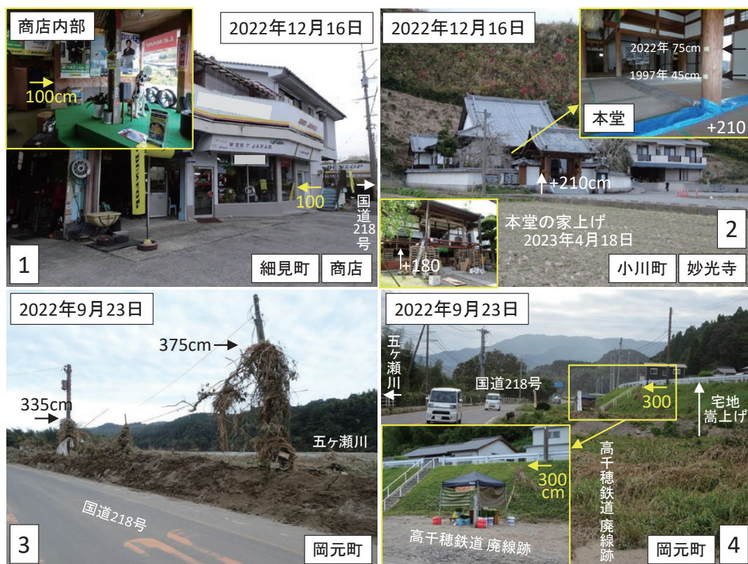
写真3 延岡市細見町・小川町・岡元町③における建物の浸水被害 (写真の位置は図13に記載)
