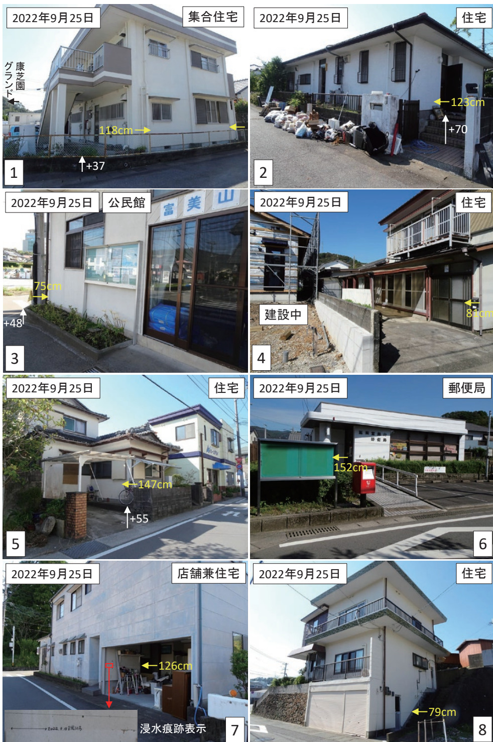
写真1 延岡市富美山町①における建物の浸水被害 (写真の位置は図9に記載)
