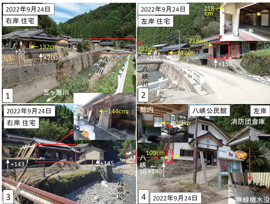
写真6 北方町八峡地区⑥における建物の浸水被害 (写真の位置は図19に記載)
