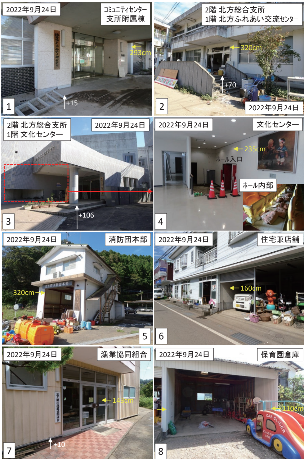
写真4 北方町川水流地区④における建物の浸水被害 (写真の位置は図15に記載)
