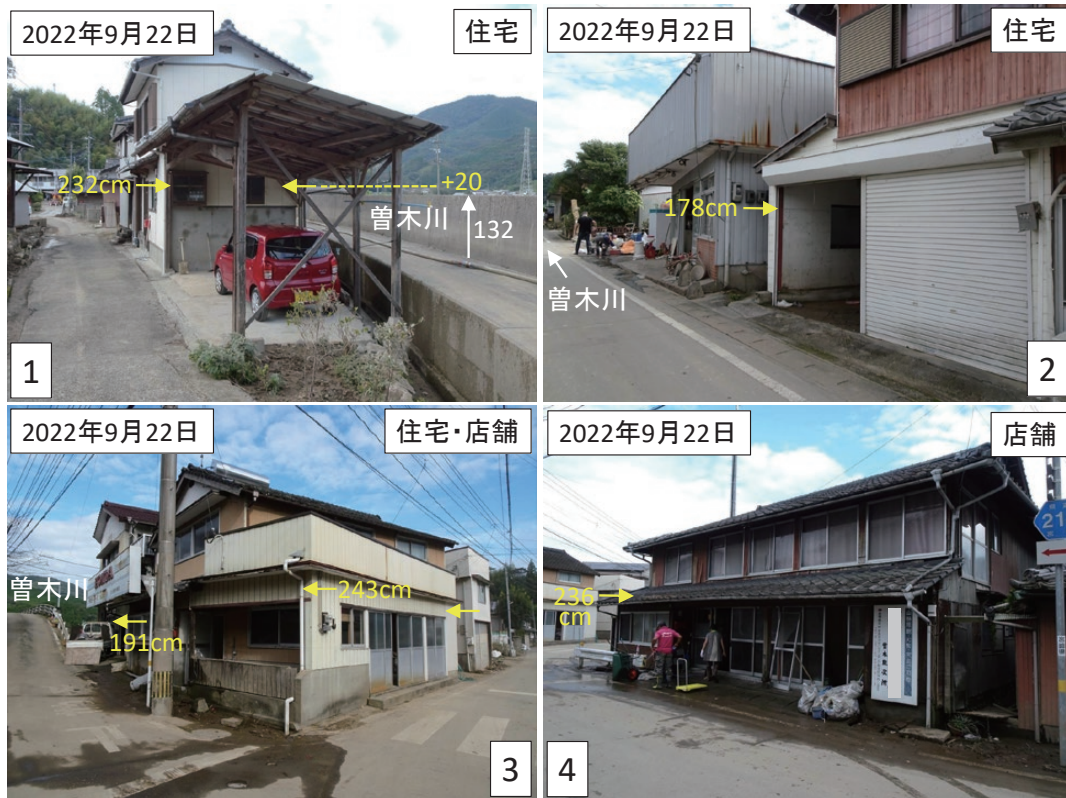
写真5 北方町曾木地区⑤における建物の浸水被害（写真の位置は図17に記載）
