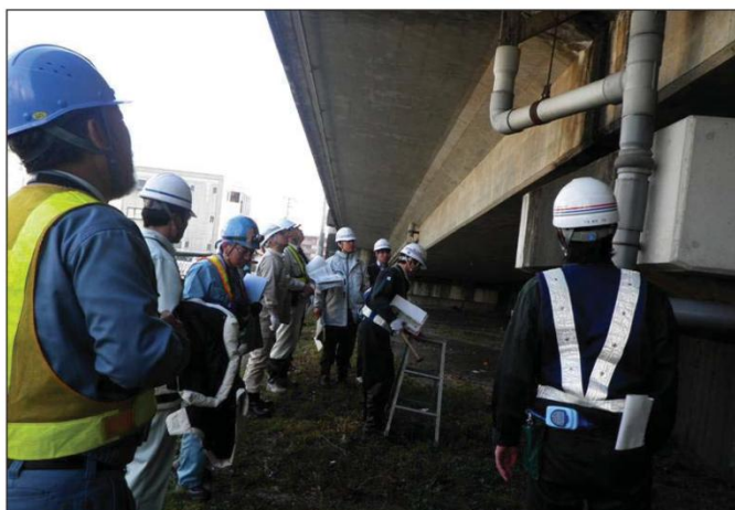
橋梁のコンクリート損傷箇所の診断状況（平成24年度）
