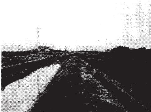
写真2 大谷川洗堰付近 7月20日、筆者撮影。右が大谷川。前後の堤高より1m程低くなっている。
