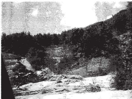
写真10 茂朱南大川上流部の斜面崩壊
