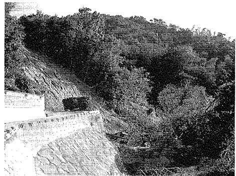
写真4 兵庫県津名町里地区の斜面崩壊 2004年11月8日筆者撮影。屋内にいた1名が死亡。
