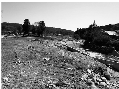
写真5 滝集落箕の子川左岸側
