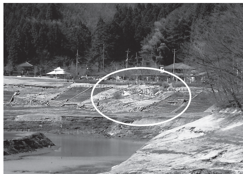
写真2 貯水池奥部の円弧すべり被害
