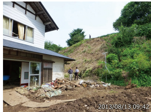
写真2 花巻市大迫町の斜面崩壊による家屋倒壊で1名が死亡した現場
