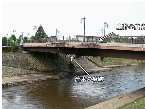
写真1 黒川の泉大橋における流木や塵芥の痕跡 (位置は図9に記載)
