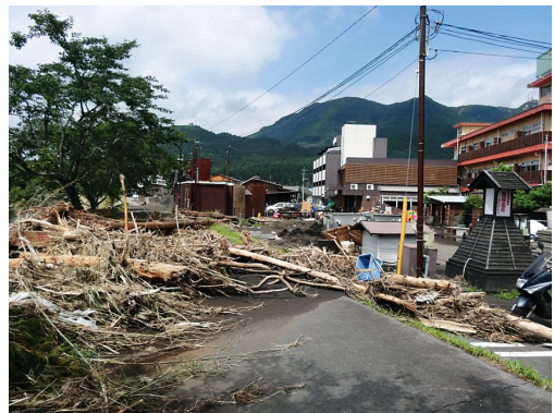
写真2 洪水による浸水被害を受けた温泉旅館 (位置は図9に記載)
