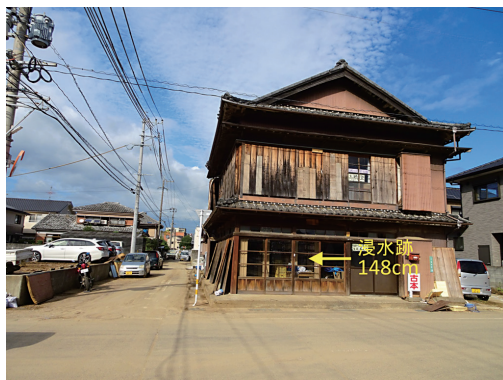
写真6 店舗における浸水の痕跡(宮本町)(2017年9月28日、山本晴彦撮影)
