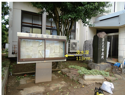
写真7 津久見市役所の玄関前に設置された掲示板における浸水の痕跡(宮本町)(2017年9月28日、山本晴彦撮影)
