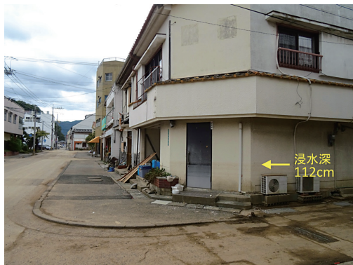
写真1 店舗における浸水被害(高洲町)(2017年9月28日,山本晴彦撮影)
