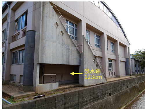
写真11 津久見高等学校の体育館における浸水の痕跡(大字津久見)(2017年9月28日、山本晴彦撮影)
