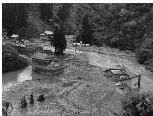
写真1 可動閉塞により水没した木籠集落
