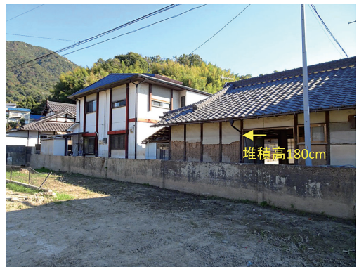
写真13 大屋大川の氾濫により土砂が堆積した住宅の被害 (2018年11月4日撮影)
