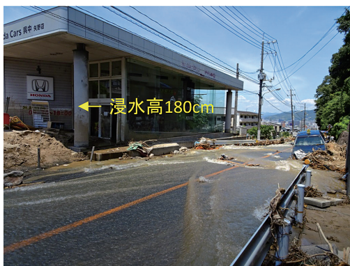
写真4 矢野川の氾濫により泥流が直撃した店舗と県道34号線の状況 (2018年7月10日撮影)
