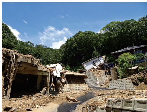
写真6 「梅河ハイツ」における土石流により倒壊した住宅の被害状況 (2018年7月10日撮影)
