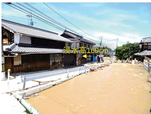
写真3 宮下川の洪水により床上浸水した家屋 (2018年7月10日撮影)
