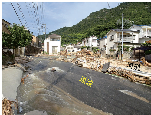
写真11 大屋大川の河道への土砂堆積と道路へ溢れた河川水 (2018年7月11日撮影)
