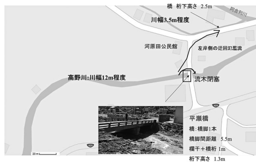
図3 高野川流域における左岸側迂回流の流路と平瀬橋(2018.7.13 河原田地区)
