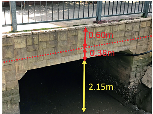
写真11 宝町を流れる河川の浸水痕跡の位置。数値はレーザー距離計による測定値。(2019年4月6日、著者撮影)
