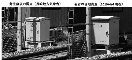
図14 JR長崎線宝町踏切の信号制御BOX。付着痕跡の位置を破線で示す。
