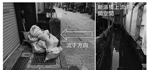
写真8 銅座町新道橋の状況 (2019年3月25日著者撮影)
