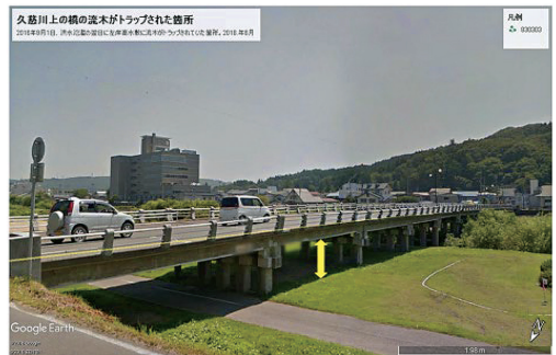
図9 上の橋に流木が捕捉された水害2年後(2018年6月)の同一箇所の原状復旧状況
