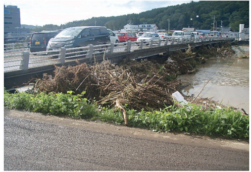
図7 上の橋上流左岸からみた流木の捕捉状態
