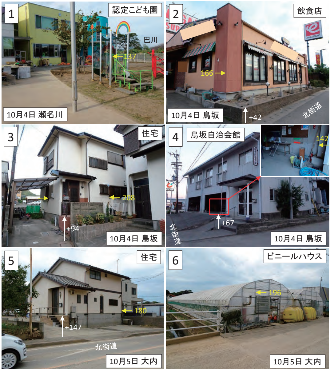
写真1 ①～⑥ 瀬名川・鳥坂・大内における浸水被害の状況（地盤からの高さ（cm））
