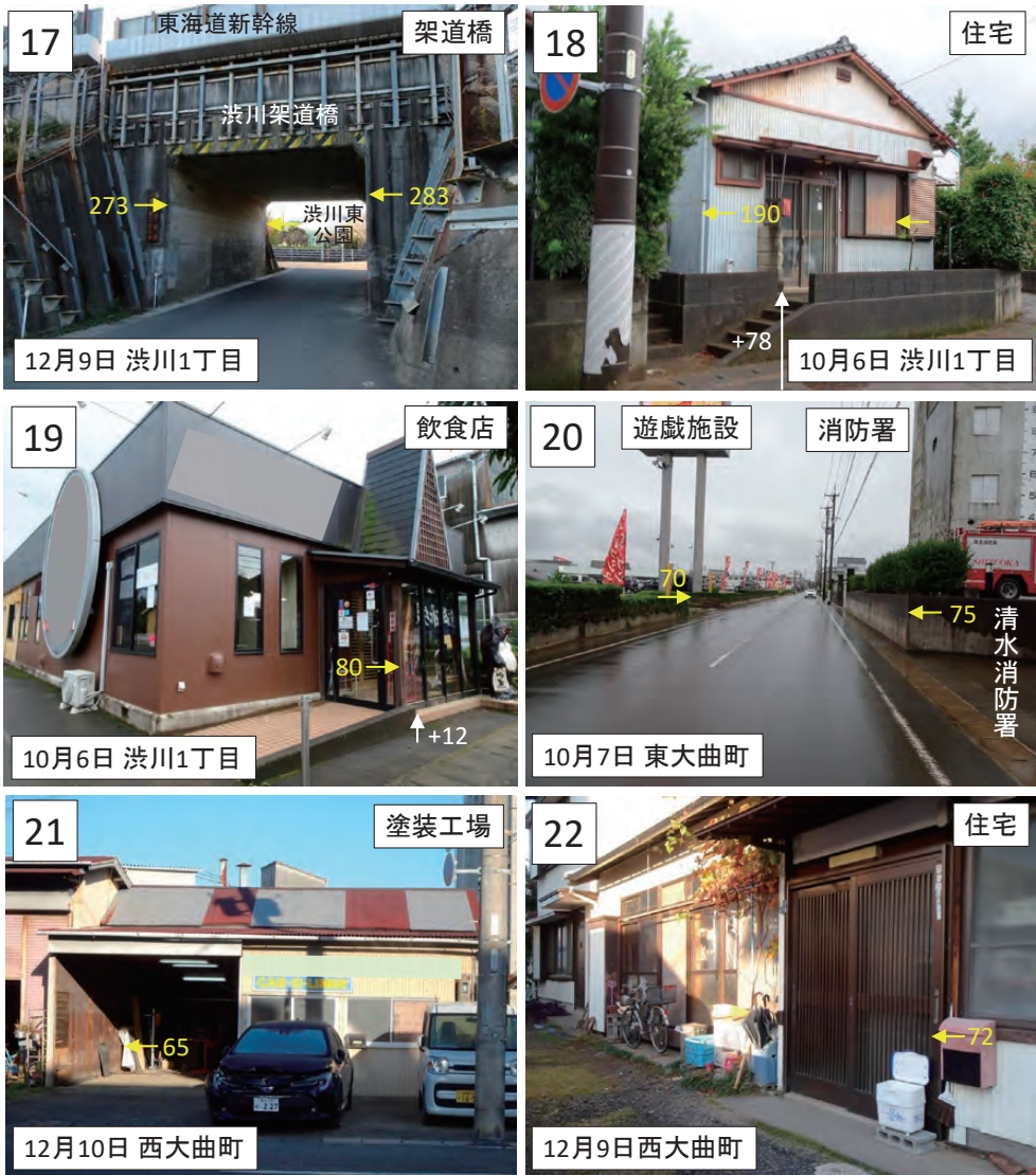
写真 3 17~22 渋川 1 丁目・東大曲町・西大曲町における浸水被害の状況 (地盤からの高さ (cm))
