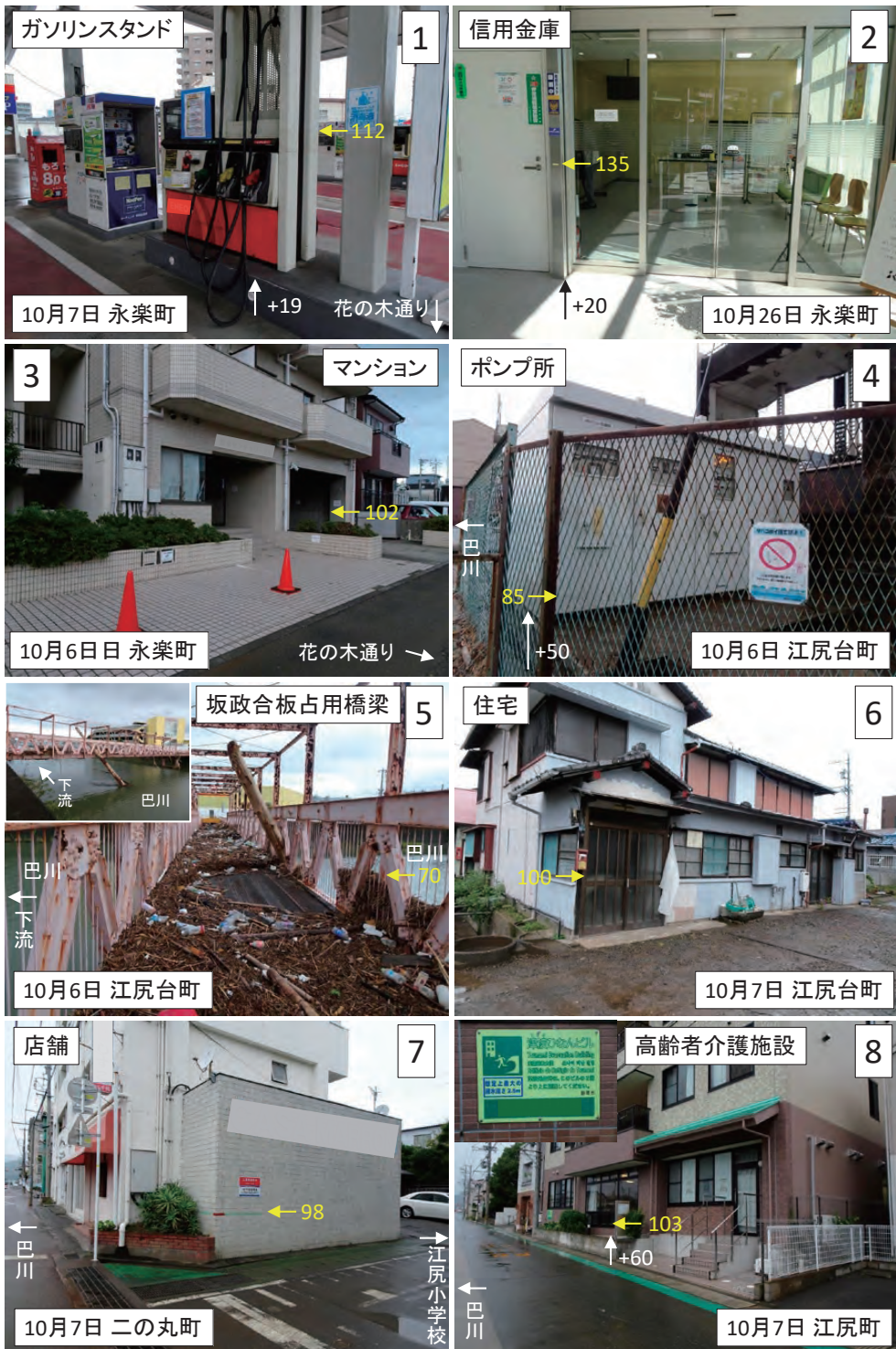
写真3 ①～⑧ 永楽町・江尻台町・二の丸町・江尻町における浸水被害の状況(地盤から高さ (cm))
