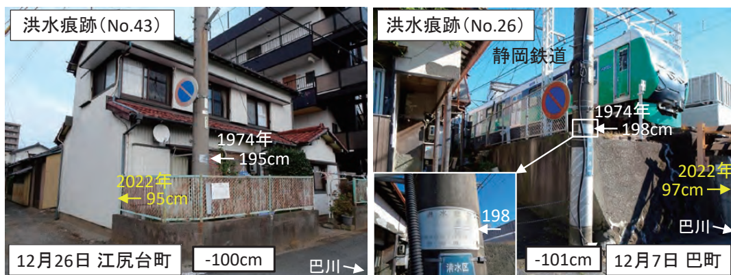
写真4 江尻台町 (No.43, 静岡土木事務所より提供を受けた際に記された番号) と巴町 (No.26) における1974 (昭和49) 年「七夕豪雨」と2022 (令和4) 年9月豪雨における浸水深の比較
